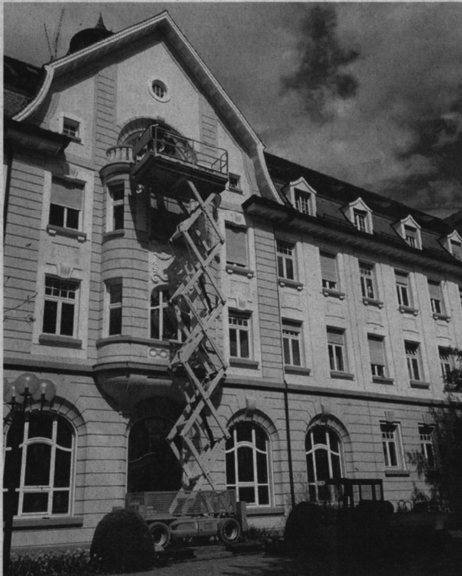
Die Fachberater von Schwenk empfahlen den Einsatz einer 14-m-„BiEnergie“-Scherenarbeitsbühne, wahlweise mit Elektro- oder Dieselantrieb.
