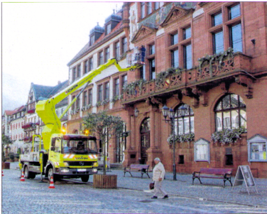
Einfach und sicher: Arbeitseinsatz an der Fassade des historischen Wolfacher Rathauses.
